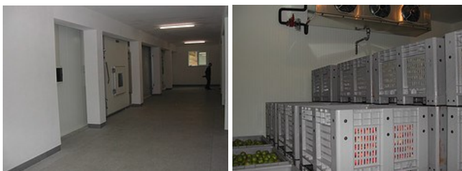
Figura 4.10. Răcire forțată la tiraj de vegetale recoltate în ambalaje ventilate (net 4.6, accesat 2024)
