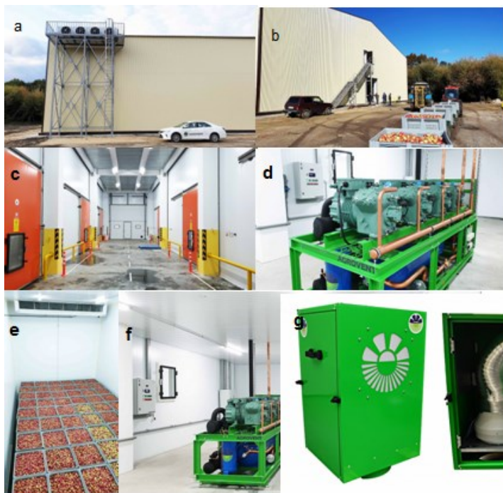
Figura 4.23. Celula cu atmosferă modificată și refrigerare pentru depozitarea vegetalelor: pereți de construcție specială (a); depozitarea merelor în containere de plastic (b); celule de depozitare cu atmosferă modificată care au o suprafață alocată de 105 m 2 (c); generatorul de atmosferă modificată cu multiserver; celule pline(d,e); sistemul de eliberare a atmosferei modificate (f), sistem de generare a CO 2 (g) (net 4.15, 2024)
